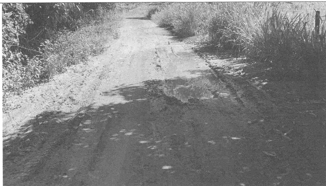
FOTO 26 – INICIO DO TRECHO BARRIGUDA A SITIO NOVO
