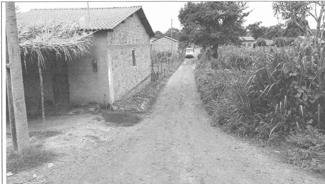
FOTO 05 – INICIO DO TRECHO MARIANOPOLIS A PORTO DA Balsa
