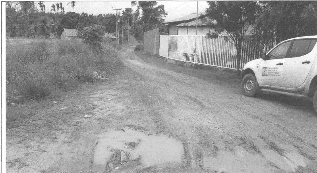
FOTO 15 – INICIO DO TRECHO SANTINHA A SÃO MANOEL
